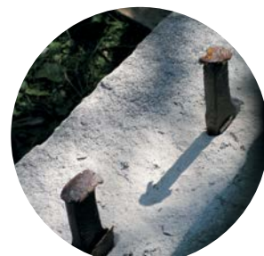
Kliny osadzone w kamieniu, fot. Emil Kania
