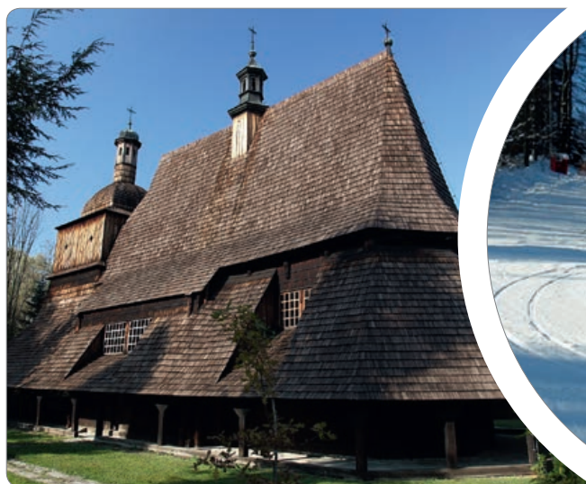
Drewniany kościół w Sękowej. Fot. A. Nowak
