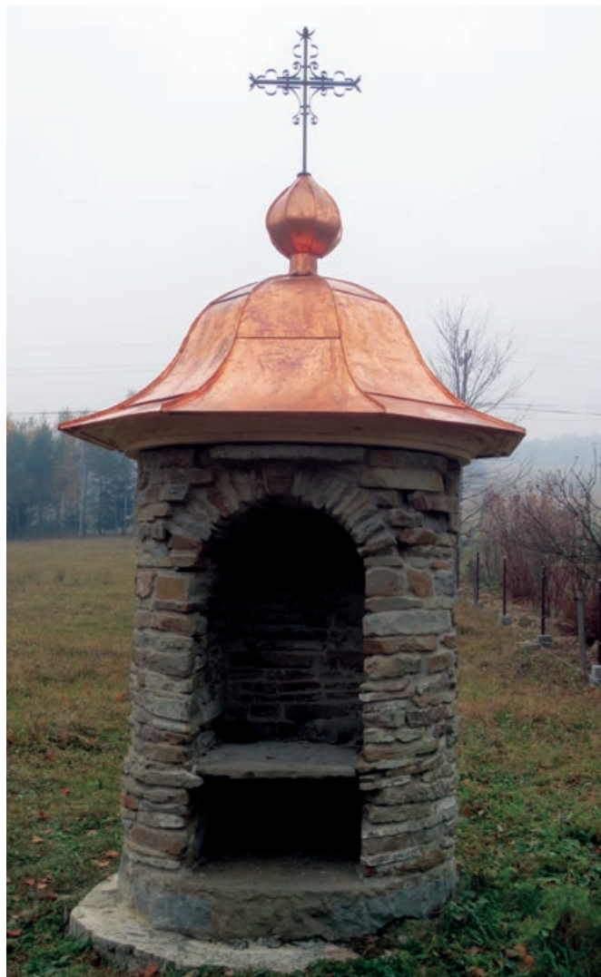
2a. Stan po odbudowie i rekonstrukcji chełmu, X 2015.
