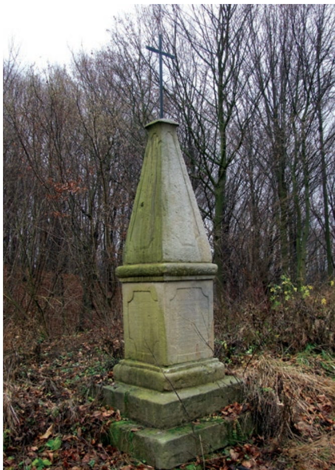
6a. Stan w 2013 po remoncie wykonanym w V 2005.
