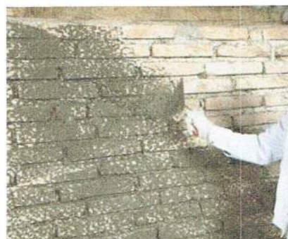
Wykonanie obrzutki z zaprawy PCI Saniment® 04 poprawia przyczepność kolejnych warstw.
