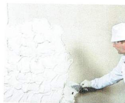
Nakładanie drugiej warstwy zaprawy na „przezsane” pierwszej warstwy PCI Saniment® 02.
