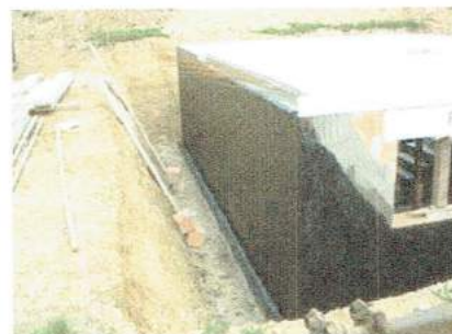
Uszczelnienie zewnętrzne ściany piwnicy z betonu przy zastosowaniu PCI Pecimor® 2K. Wygodna obróbka dzięki wypełnieniu polistyrenowemu.
