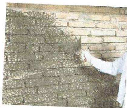
Wykonanie obrzutki z zaprawy PCI Saniment® 04 poprawia przyczepność kolejnych warstw.
