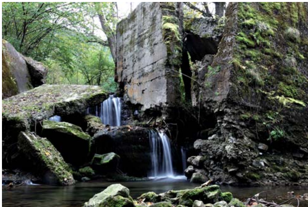
Fragment starego mostu
