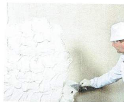
Nakładanie drugiej warstwy zaprawy na „przezsanej” pierwszej warstwie PCI Saniment® 02.
