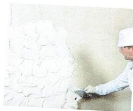
Nakładanie drugiej warstwy zaprawy na „przezsanej” pierwszej warstwie PCI Saniment® 02.
