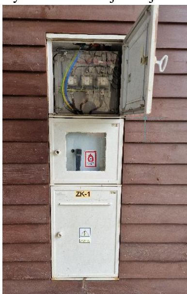
Rys. 3. Punkt przyłączenia dla dwóch stacji ładowania na terenie parkingu OEM im. Jana Szafrąńskiego
