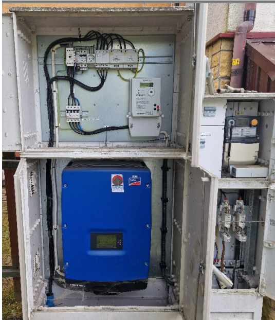
Rys. 5. Punkt przyłączenia stacji ładowania na terenie parkingu przy budynku Dyrekcji Magurskiego PN
